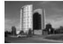
12/ Prague Towers Tlumačovská 26 Zdeněk Frey, Ivan Hořejší 2011
