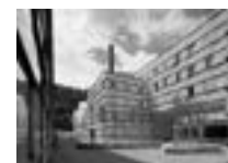
11/ Cornlofts Šaldova Šaldova Baumschlager Eberle 2007–2009
