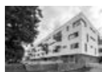
10/ Bytový dům KOTI Hostivař II Zemské právo 5 Hlaváček a Partner 2014
