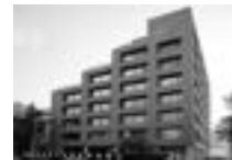
11/ Radnice Prahy 7 U Průhonu 38 Atelier Bod Architekti 2017–2020
