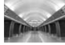
6/ Stanice metra Jinonice Radlická Miroslava Derynková 1988
