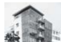
15/ Administrativní budova Hájkova Hájkova 22 W/4 Architekti 2000
