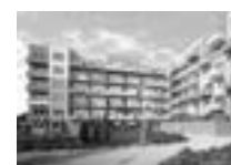
16/ Bytové domy Javorová čtvrť Ulice Mantovská a Modenská Central Group 2018–2020
