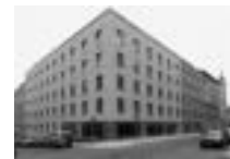
2/ Polyfunkční dům Eucon Ulice Chlumova a Štítného Fránek Architects 2002–2005
